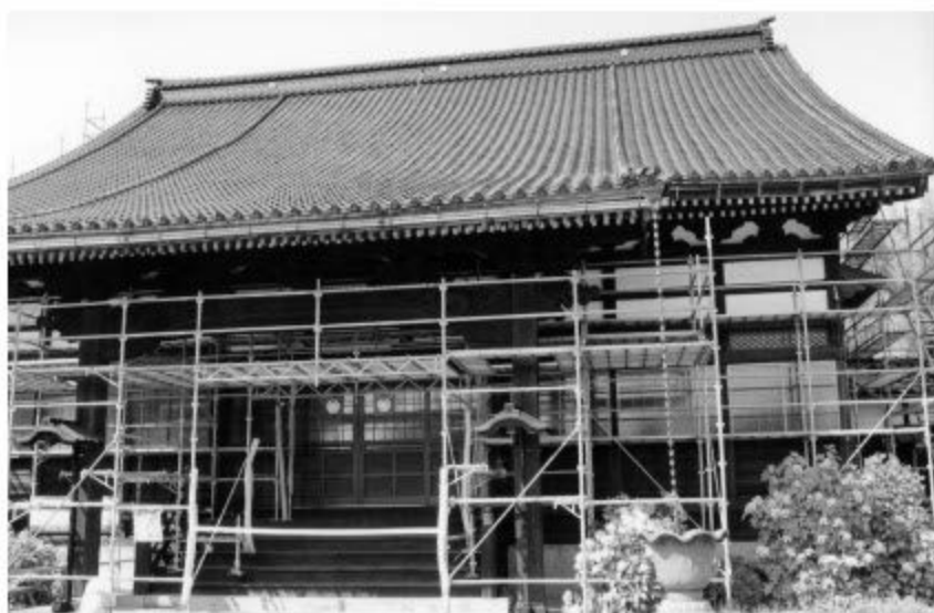
改修工事完成目前の本堂 6月17日撮影
